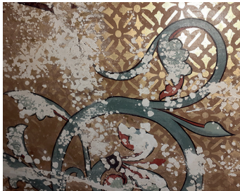
Vue d'un rinceau - Détail en cours de restauration - © Ville de Saint-Cloud, musée des Avelines / G. Piagnoul
