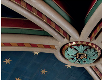
Vue de la voûte étoilée - Détail après restauration - © Groupement Boual
